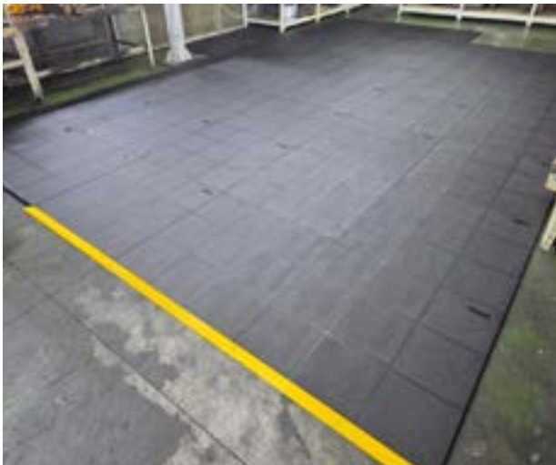
정돈된 작업 구역 조성과 시설·바닥 보호
